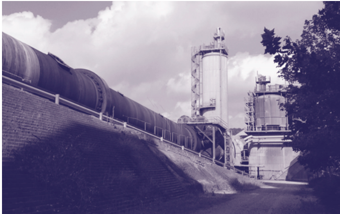
Figuur 10 Klinkeroven ENCI in Maastricht: lengte 200 meter, diameter 5,5 meter, productiecapaciteit 950.000 ton per jaar
