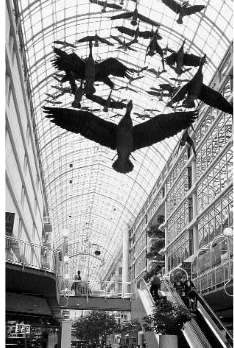
Afbeelding 5.37 Eaton Center (Toronto, Canada, 1977-1979) bracht volgens de vakwereld weer 'emotie in de mall'. Ontwerp: Zeidler Roberts, Toronto. Foto: Dion Kooijman, 1997.
