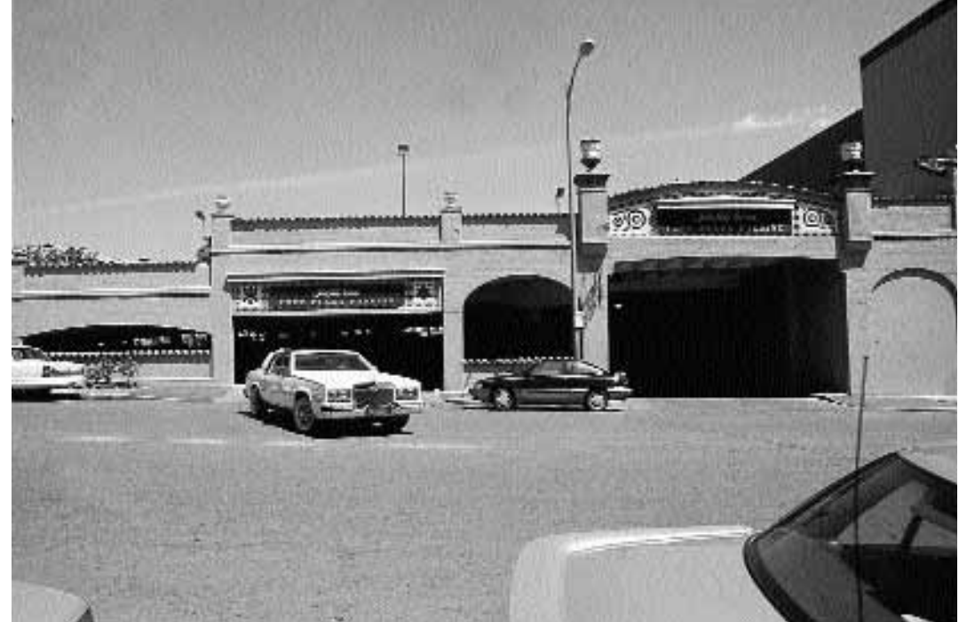
Afbeelding 5.11 Een van de eerste parkeergarages bij een gepland winkelcentrum, gebouwd in de jaren twintig (Country Club Plaza, Kansas City). Foto: Dion Kooijman, 1997.
