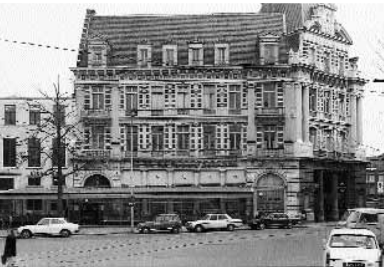
Afbeelding 2.20 Entree Passage aan Buitenhof, 28-2-1974. Ontwerp: H. Rieck (architect) en W.H. Mortiaux (aannemer). Bron: DSO/Monumentenzorg, HMS/AHD, Gemeente Den Haag, neg. nr. 25060.
