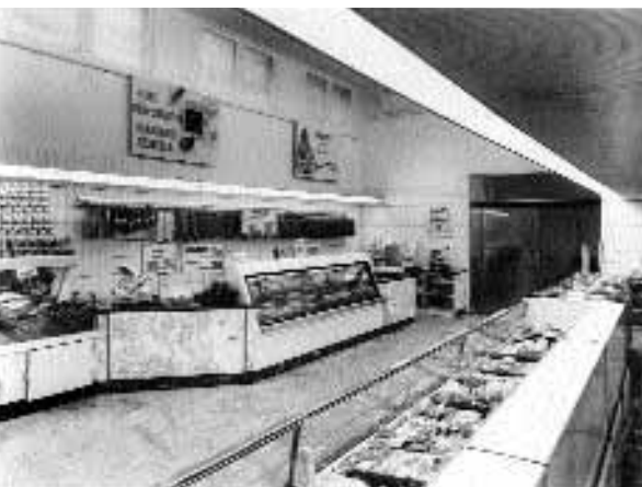
Afbeelding 4.12 Slagerij supermarkt van Albert Heijn, Nieuwe Binnenweg, Rotterdam, 1955. Bron: Albert Heijn Museum, Zaandam.
