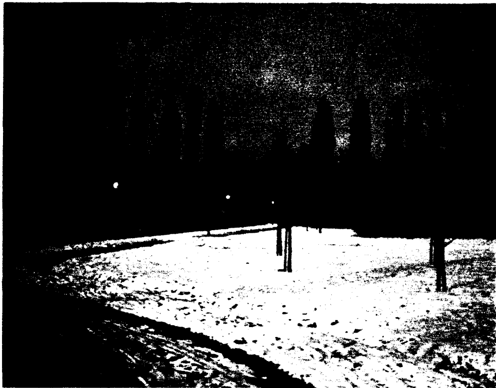
Het bouwterrein kijkrichting Noord-West
