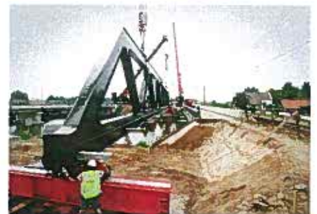
13. Spoorbrug De Haandrik bij Coevorden-Grambergen heeft twee vakwerkliggers met gelaste buizen.
