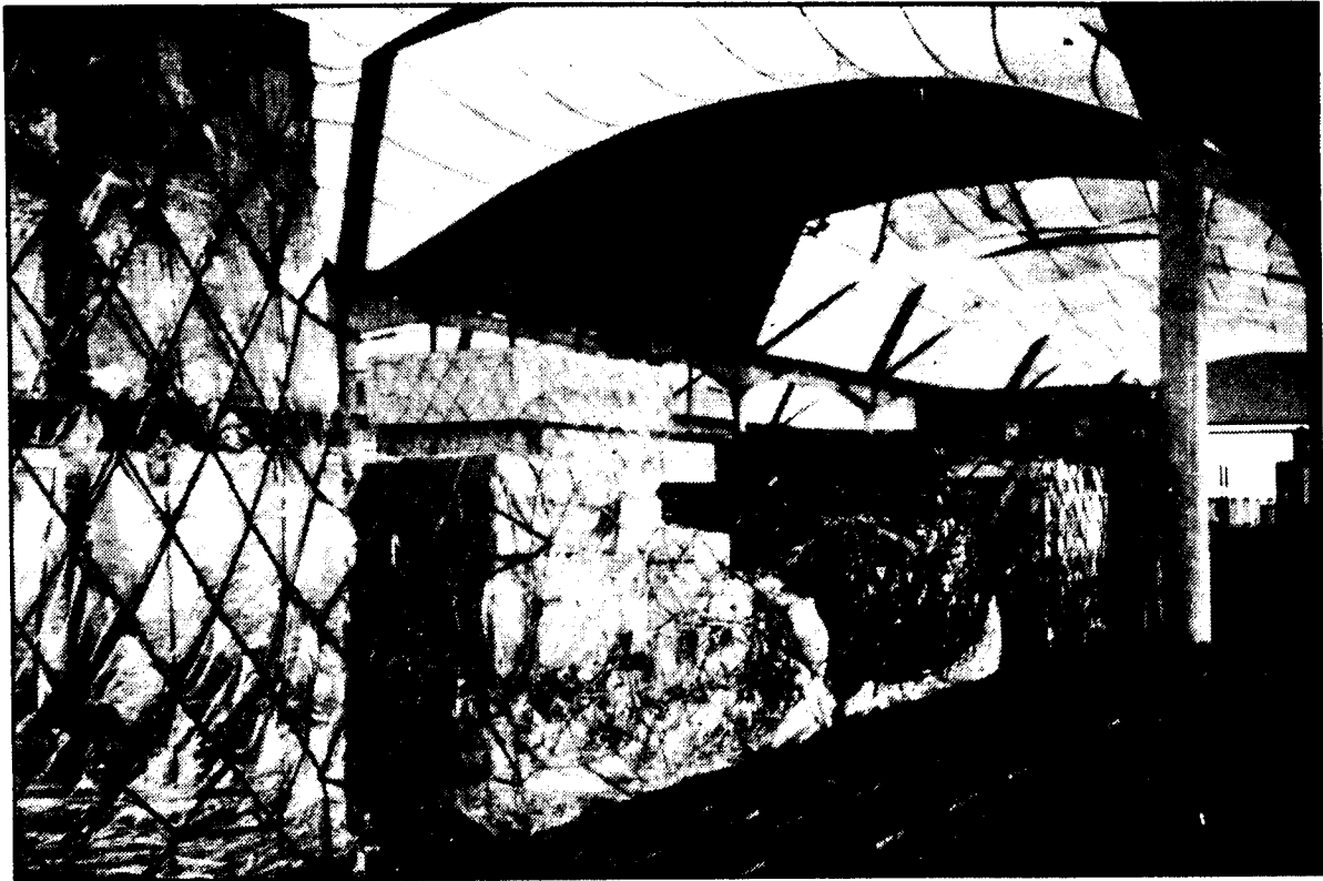
• Le BOP (Bâtiment d'Ordonnancement des Pallettes) op het vliegveld Charles de Gaulle te Parijs, zonder muren en met een zelfreinigend kunststofdak. Hier worden volledige ladingen voor Boeing 747 vrachtvliegtuigen klaargezet.
