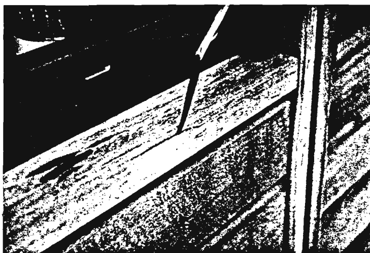
Afb. 8 Schilfering iroko ( Fl_{p,2} ). Treedt op bij 'natte gevels'.
