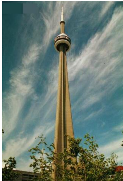
Figuur 3.1: voorbeeld van een toepassing van verticale voorspanning Ostankino tower in Moskou en CN tower in Toronto
