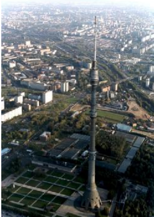
Figuur 3.1: voorbeeld van een toepassing van verticale voorspanning Ostankino tower in Moskou en CN tower in Toronto
