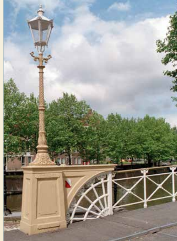
Bruggenhoofd van de gerestaureerde Weerbrug in 1995. De voet van de lantaarn vermeldt 'Utrechtsche IJzergieterij 1862' en 'Gieterij Hardinxveld 1994'.
