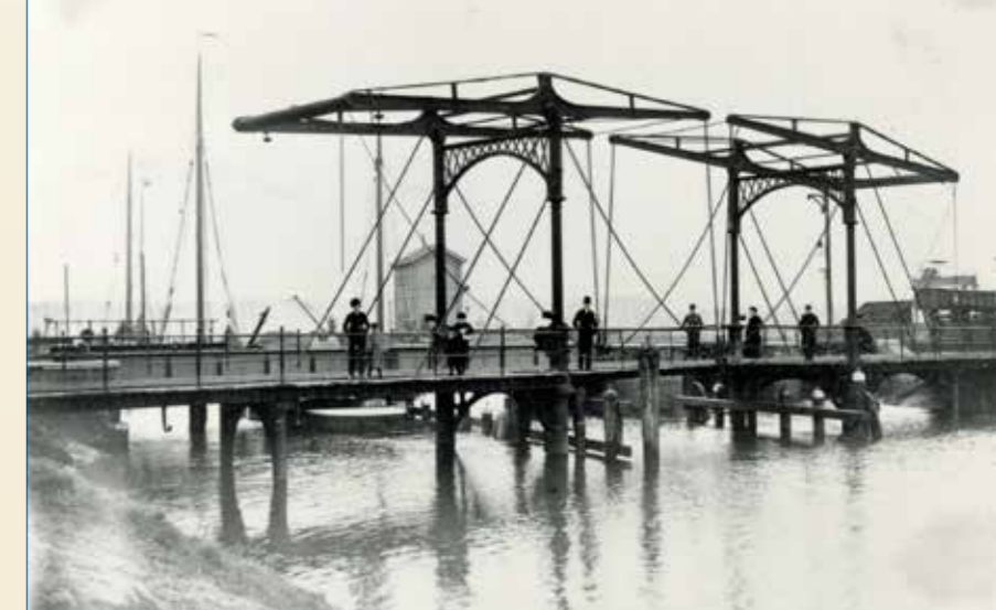
Door de Utrechtsche IJzergieterij in 1866 opgeleverde ophaalbrug over de Mark in Breda. De brug maakte in 1893 plaats voor een spoorbrug.
