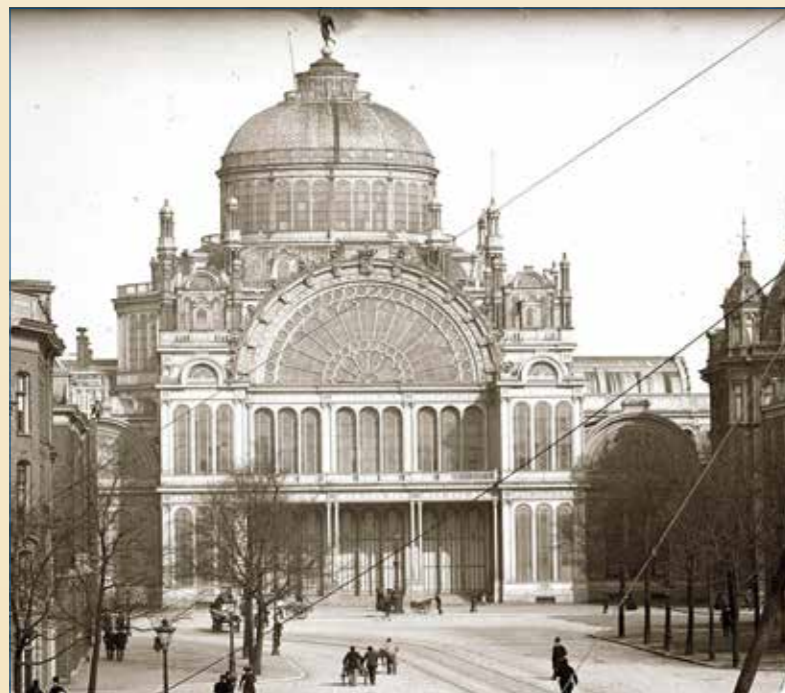
Deel van het Paleis voor Volksvlijt in Amsterdam met de door de Utrechtsche IJzergieterij vervaardigde koepel.
